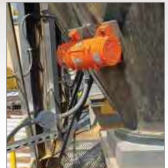
Aplicación de 2PX a tolvas de compensación.
