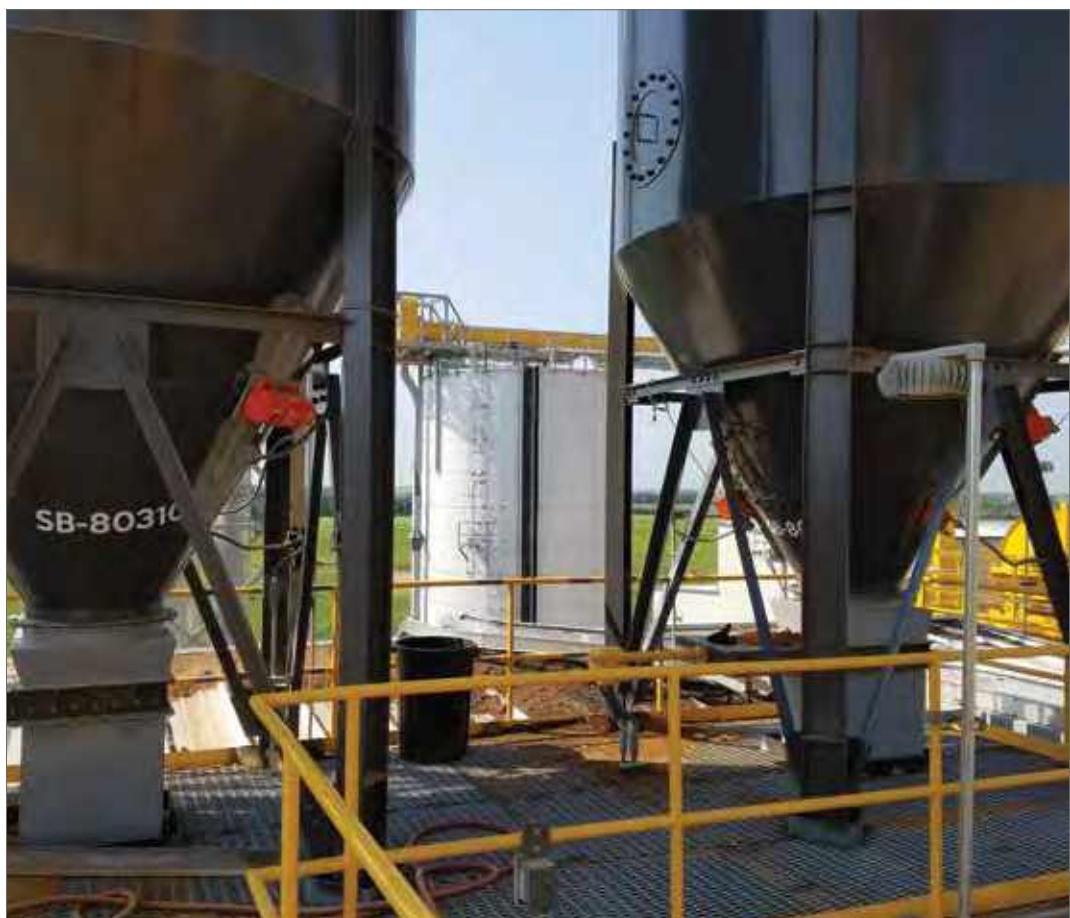
Varias unidades antideflagrantes Modelo 2PX (página 52) se usan en estas tolvas de compensación y descarga dobles.
