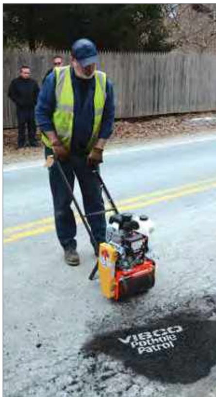
Abajo: VIBCO ofrece distintos rodillos y compactadoras (páginas 70 y 71) para reparaciones duraderas de ojo de buey, y compactación de tierra o asfalto.
