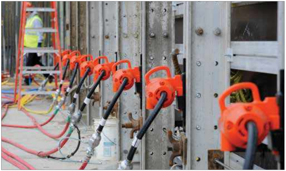
Los Vibradores VIBCO están habituados a las aplicaciones de hormigón, ya sea para columnas, paredes, losas, cimientos o premoldeado. A continuación, nuestro Modelo SVRFS (páginas 30 y 31) con Soporte Stik-It™ (página 65) se está usando para reparar un puente en RI, y a la izquierda, está colocado en un encofrado para columnas de hormigón. En la imagen superior, nuestro SVRWS (páginas 30 y 31) está siendo usado con un soporte UWF para lograr una excelente transferencia de la vibración. VIBCO tiene soportes que funcionarán bien con cualquier encofrado de hormigón, incluso si es de madera.
