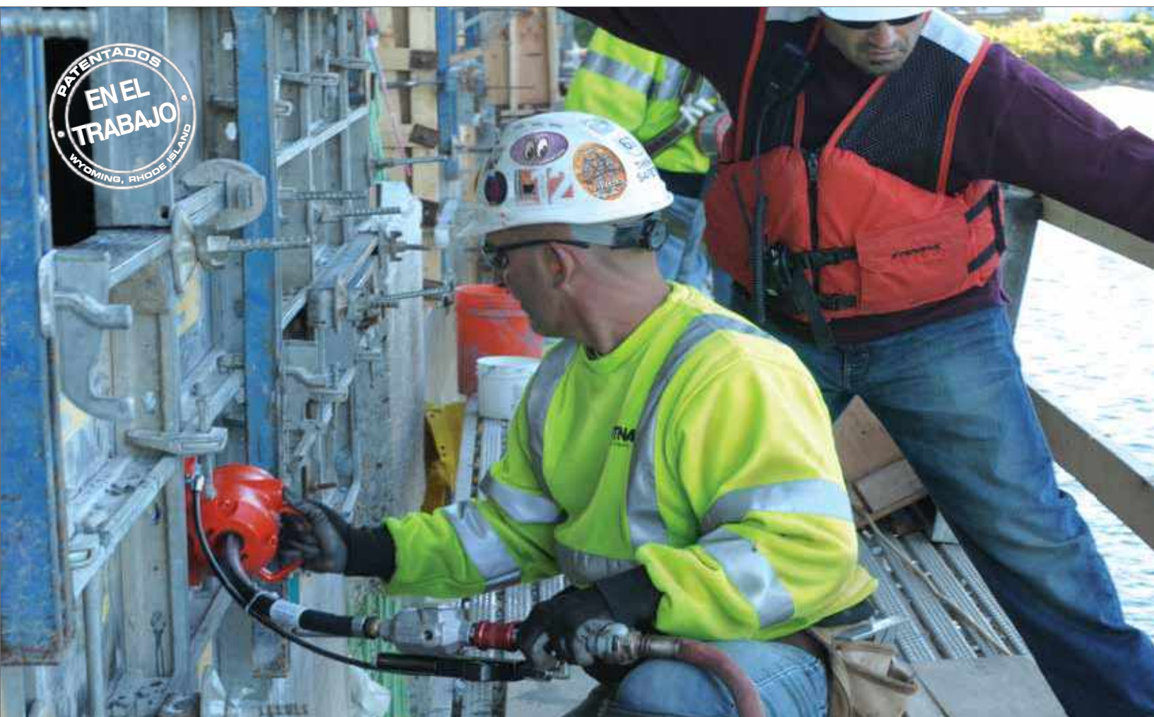
Los Vibradores VIBCO están habituados a las aplicaciones de hormigón, ya sea para columnas, paredes, losas, cimientos o premoldeado. A continuación, nuestro Modelo SVRFS (páginas 30 y 31) con Soporte Stik-It™ (página 65) se está usando para reparar un puente en RI, y a la izquierda, está colocado en un encofrado para columnas de hormigón. En la imagen superior, nuestro SVRWS (páginas 30 y 31) está siendo usado con un soporte UWF para lograr una excelente transferencia de la vibración. VIBCO tiene soportes que funcionarán bien con cualquier encofrado de hormigón, incluso si es de madera.
